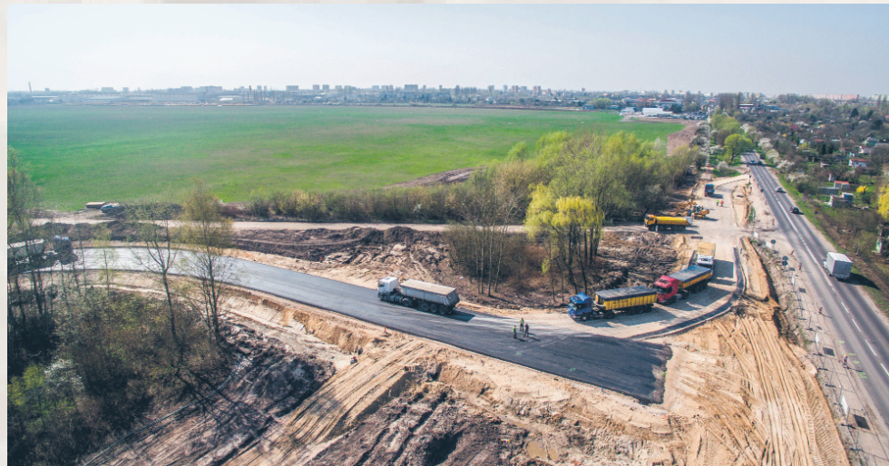
Na budowie drugiego odcinka obwodnicy, po prawej stronie ul. Bielska
