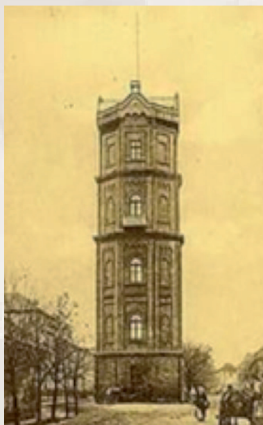
Wieżę Ciśnień w Płocku wybudowano z cegły prasowanej, zaś klatkę schodową, stropy oraz dach o łamanej konstrukcji wykonano z drewna. Co ciekawe, fundamenty i strop piwnicy zrobiono betonowe, co było pod koniec XIX w. rzeczą niespotykaną na ziemiach zaboru rosyjskiego.
