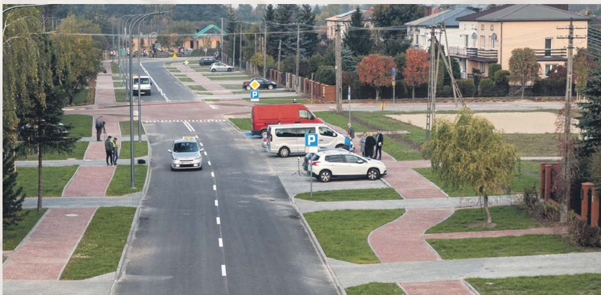
W ramach ubiegłorocznych inwestycji powstała ul. Teligi. Fot. Archiwum UMP
