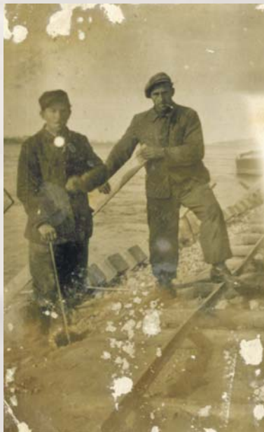
Przełom lat 30. i 40. XX w. Andrzej Tyska (z prawej) z innym pracownikiem przy budowie torów kolejowych do bocznicy w porcie na Radziwiu. Zdjęcie ze zbiorów prywatnych Magdaleny Młodziejewskiej.
